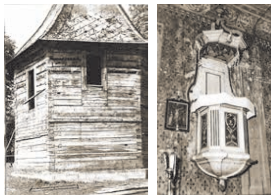
Fragment prezbiterium kościoła w trakcie rozbiórki w 1982 r. (AK K-w) oraz XVIII-wieczna ambona
