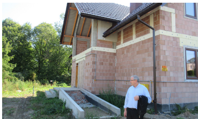
Teraz zacznie się utwardzenie i plantowanie otoczenia
